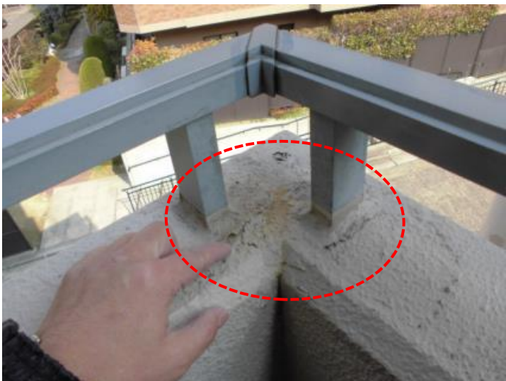
コンクリート手摺部等の亀裂に拠る塗膜劣化
