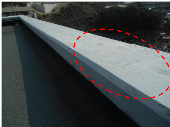
屋上パラペット天端 現況
