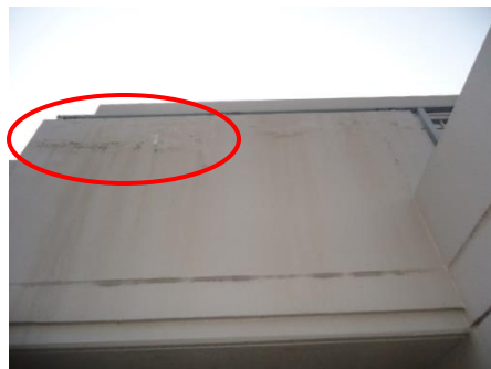
亀裂に拠る吹付けの塗膜劣化
