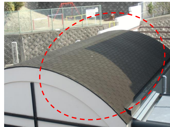
集会室屋根 現況
