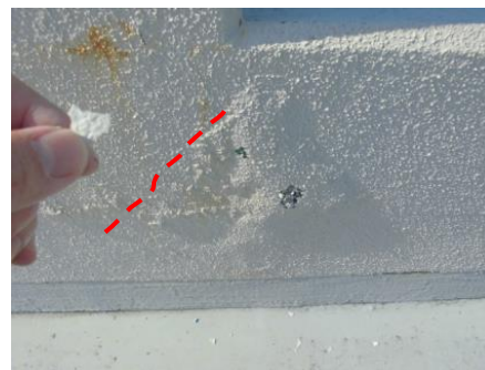
亀裂に拠る吹付けの塗膜劣化
