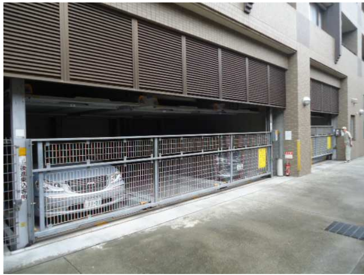
■ 3段式機械場 - 写真1
