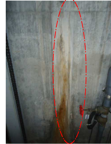
■ 壁面漏水 - 上写真4 下写真5
